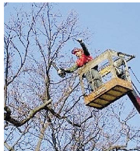
MANUTENZIONE Interessati entrambi i lati di via Archimede
