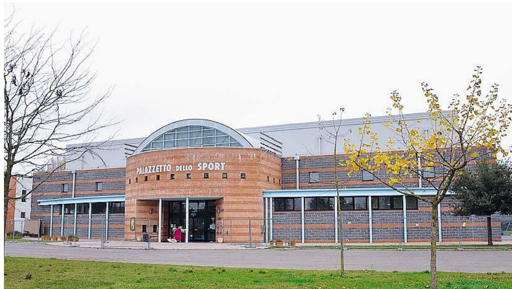
LA STRUTTURA Alcune immagini del palazzetto dello sport
