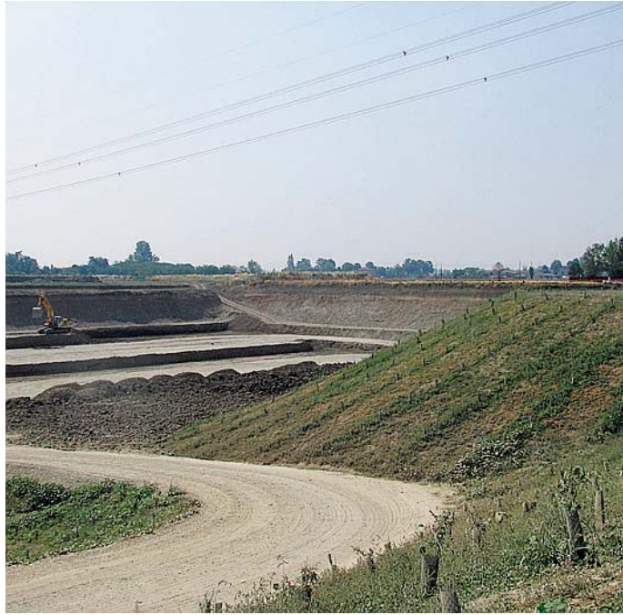
SCAVI VICINO ALLE FALDE L'immagine di una zona di cava
