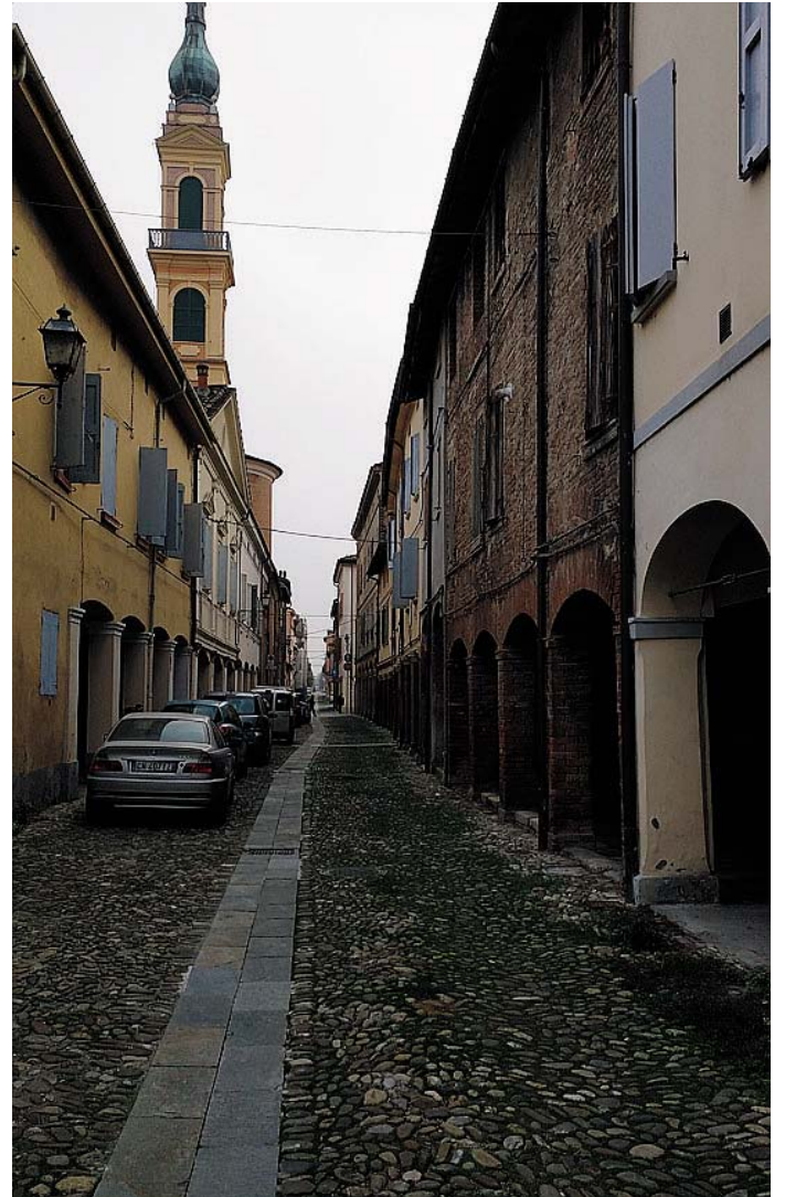
DELICATA La pavimentazione subisce danni dal passaggio delle auto. Accanto l'associazione
