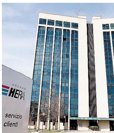
QUARTIER GENERALE Gli uffici di Hera in via Razzaboni
