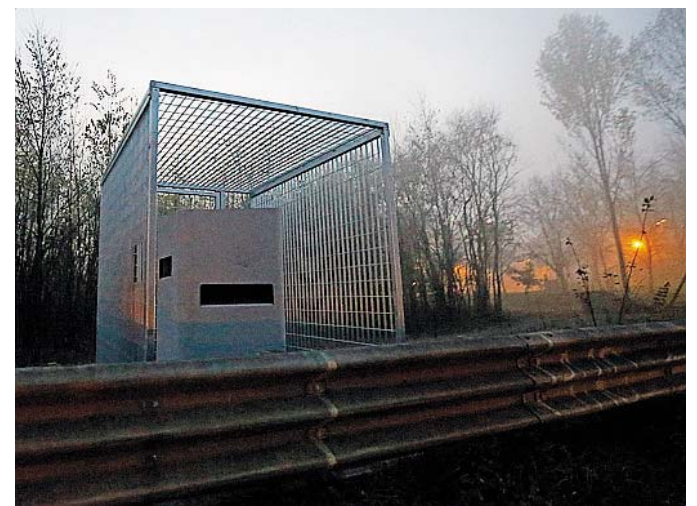
PREPARAZIONE Due scatti del box che tra pochi giorni ospiterà il nuovo autovelox
