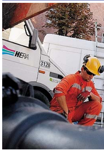
AL LAVORO Un tecnico di Hera
