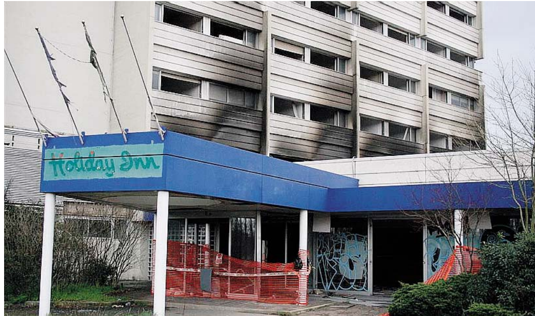
FUMO L'esterno della struttura, ex Holiday inn, come appariva ieri pomeriggio dopo l'intervento dei pompieri per l'incendio
