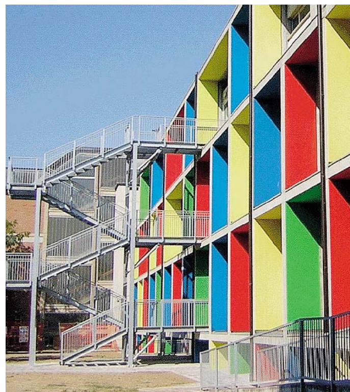
LAVORI IN CORSO Il Baggi a Sassuolo
