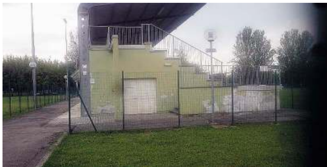
TRASCURATE Alcune immagini dell'impianto sportivo
