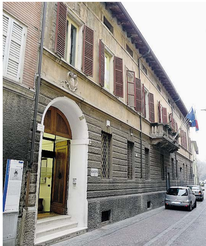
VIA FENUZZI L'ingresso degli uffici comunali di Sassuolo
