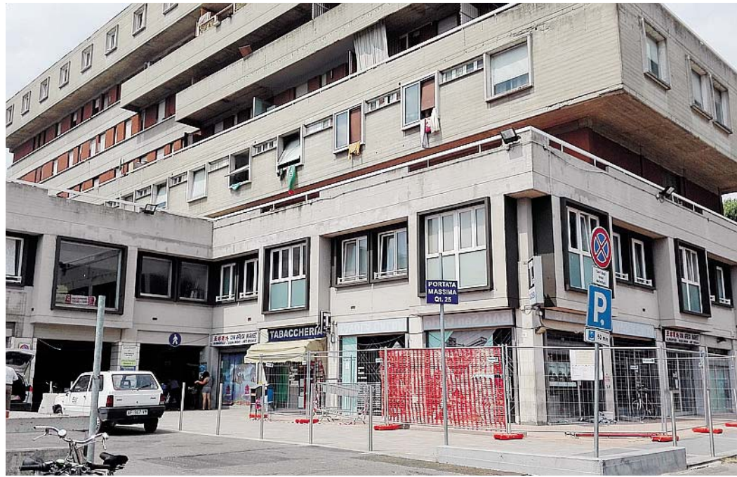
OGGI Il cantiere all'Errenord
