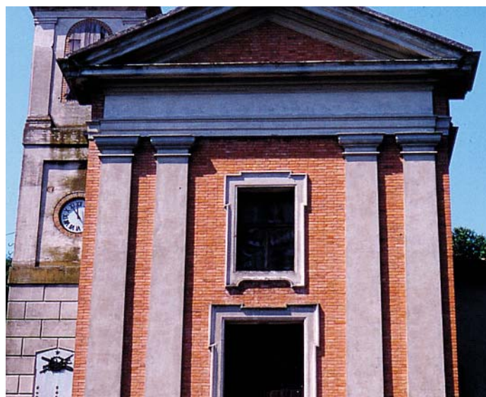
LAVORI La chiesa restaurata
