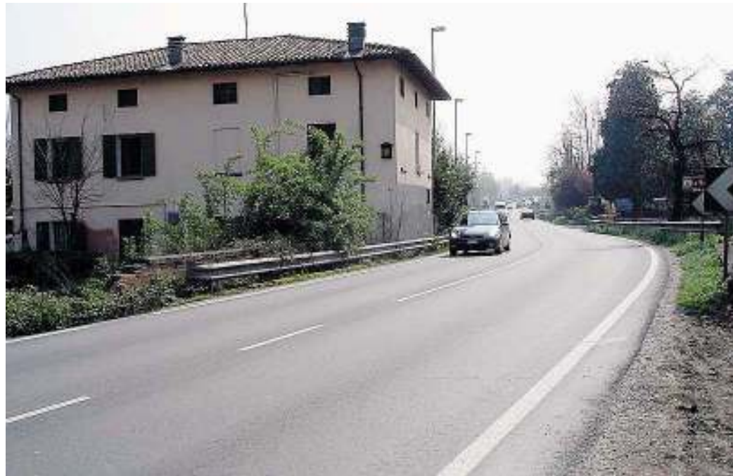
Nel 2007 è già stata realizzata la rotonda tra la strada provinciale 16 e la provinciale 623
