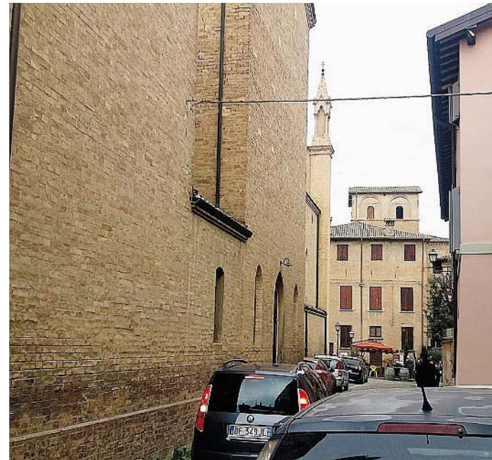
INGRESSO La porta laterale dalla quale sono entrati i ladri
