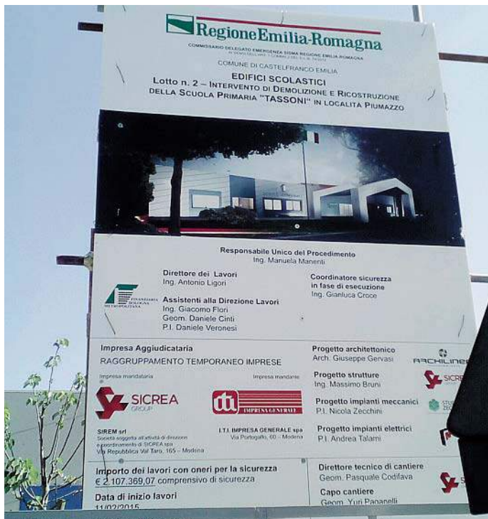
SCUOLE TASSONI Sopra, il cartello del cantiere. A sinistra, la consigliera comunale Cristina Girotti Zirotti; a destra, l'assessore ai Lavori pubblici Denis Bertonecchi
