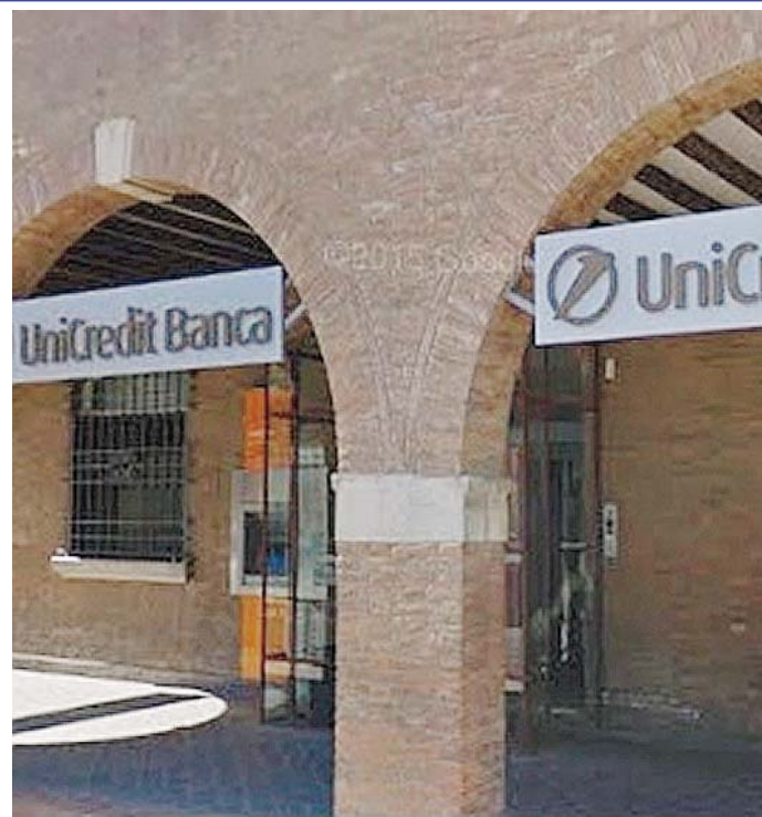
BANCOMAT Sopra, la filiale Unicredit di Castelnuovo. A sinistra, i carabinieri, che hanno inseguito e arrestato il ladro
