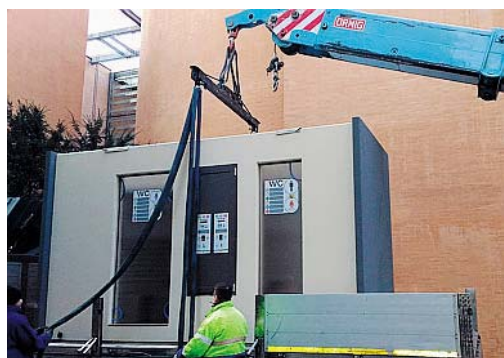
POSIZIONAMENTO Un momento dei lavori di ieri mattina
