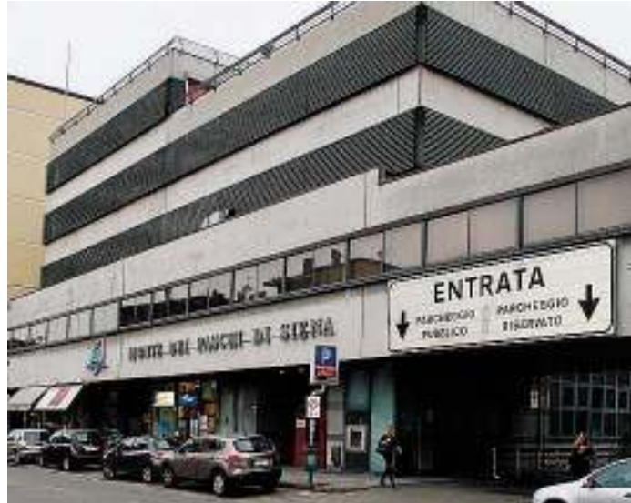
ALLE PORTE DEL CENTRO STORICO Una veduta del garage Ferrari (foto Modenatoday.it)
