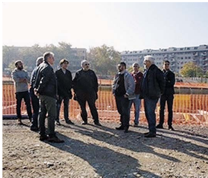
Il sopralluogo di Marino e Guerzoni lo scorso anno al cantiere Corassori. A destra il cantiere oggi
