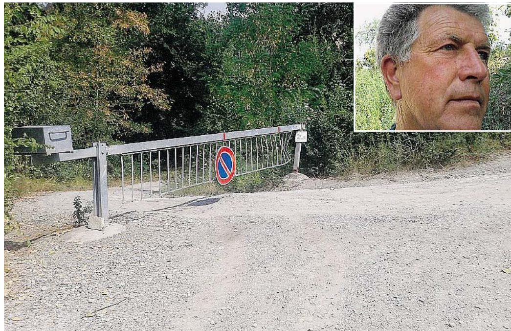
DEGRADO L'area pic-nic transennata, Virginio Leonelli e il punto informativo
