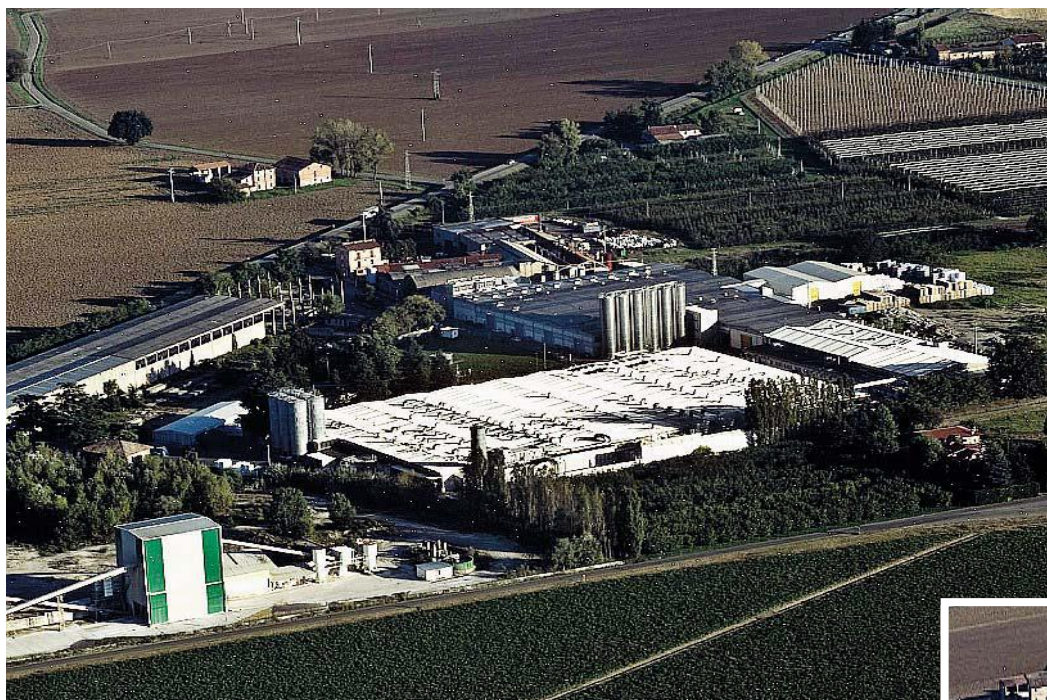
DIFFERENZE Qui sopra in grande una visione aerea della zona com'è oggi. A destra in basso nella foto grande quello che dovrebbe diventare a lavori ultimati. Nelle due foto più piccole in alto a destra la stessa zona vista dalla strada prima (più in grande) e dopo (nel riquadro più piccolo)
