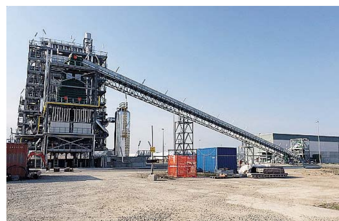
IMPIANTO La centrale a biomasse di Enel Green Power a Finale Emilia
