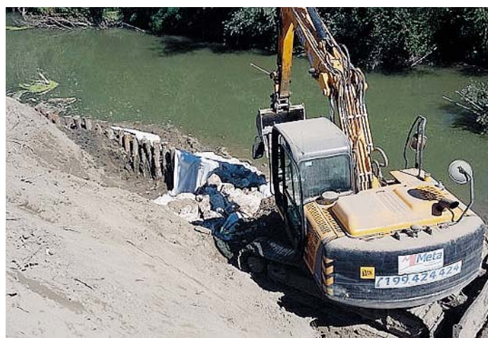
RUSPE Fervono i lavori lungo i fiumi di Bomperto
