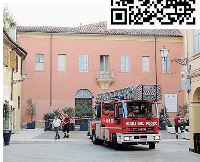
DANNI Il crollo del tetto della biblioteca qualche settimana fa
