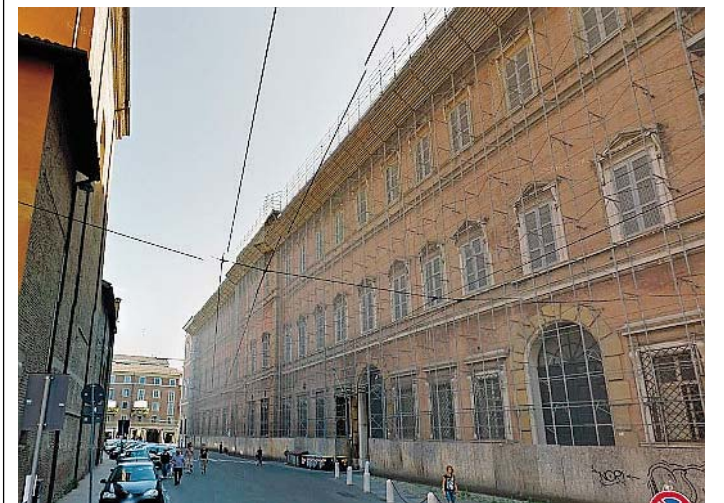
CENTRO STORICO Uno scorcio di via 3 febbraio, alle spalle dell'Accademia militare
