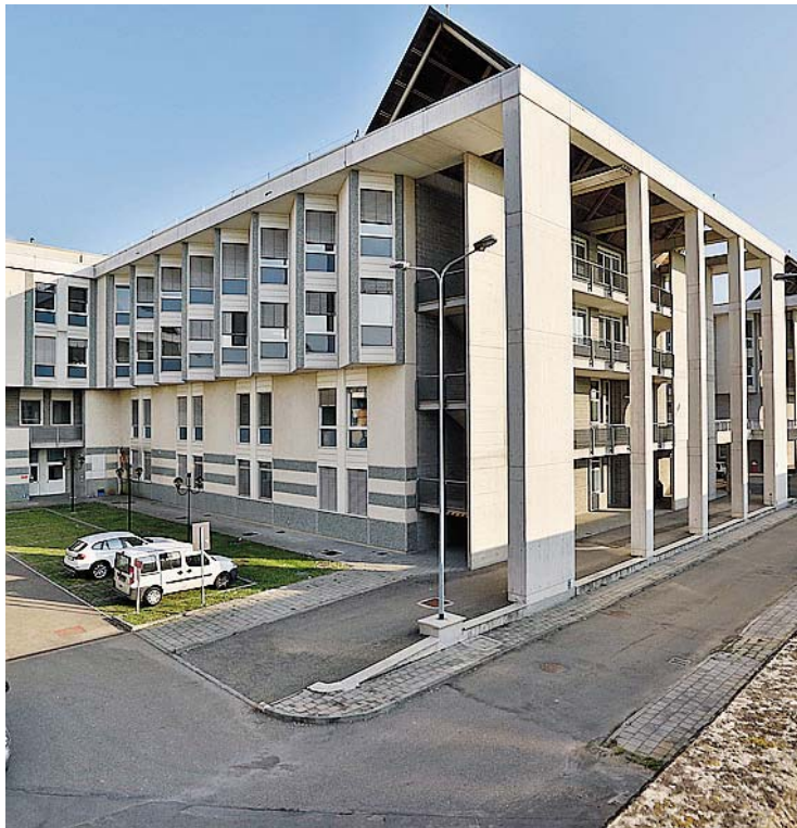
IN CORSA Una veduta dell'ospedale di Baggiovara
