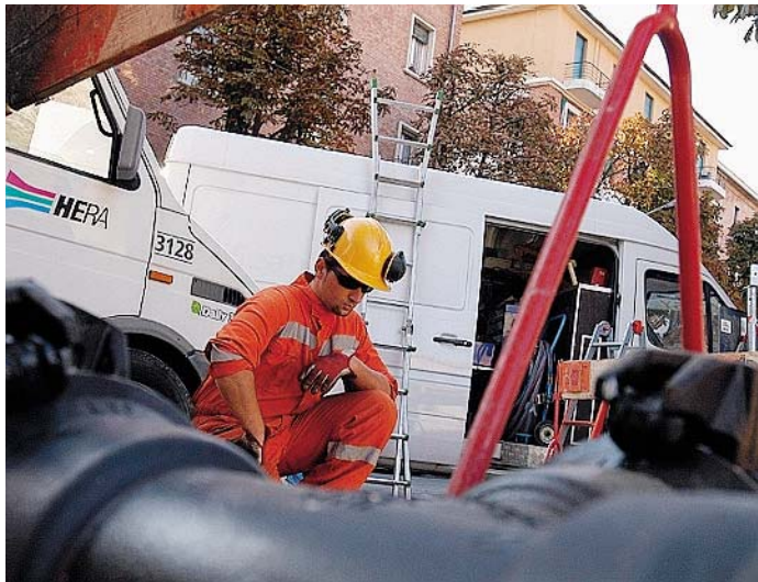
OPERAZIONI Nella foto di repertorio, tecnici di Hera al lavoro
