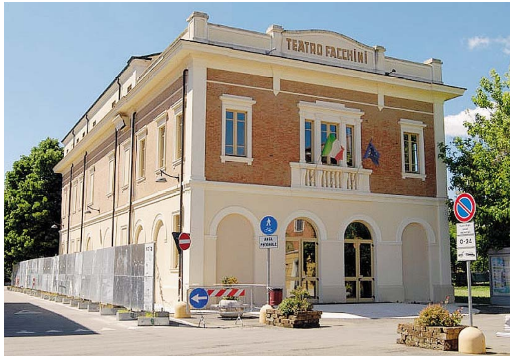
OPERE PUBBLICHE Costruito negli anni '20, il teatro dopo il sisma è stato dichiarato parzialmente inagibile per le diverse lesioni riportate
