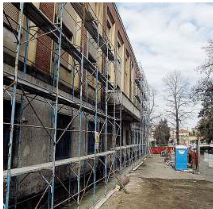
Lavori in corso al palazzo «ex Gil»
