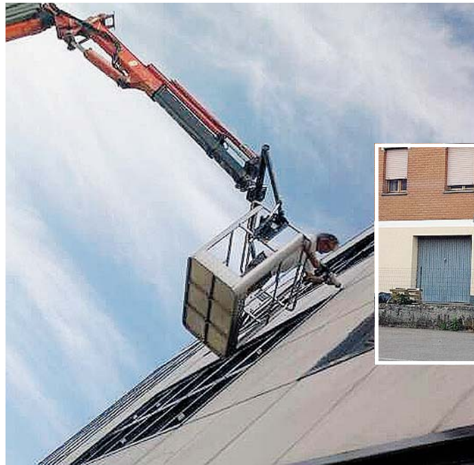
MEZZO Sopra, un mezzo con cestello (repertorio). Nel riquadro, via Novella
