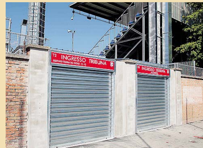
LO STADIO L'ingresso alla tribuna centrale dello stadio Cabassi
