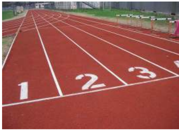
PRIMA E DOPO A destra fanghi risaliti dal sottosuolo, a sinistra la pista dopo il rifacimento
