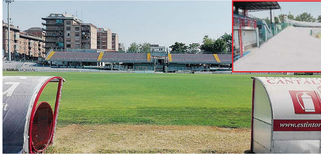
OGGI Lo stadio Cabassi necessita di lavori di adeguamento per disputare, in deroga, il campionato di serie B
