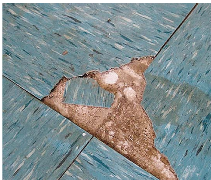
PAVIMENTI Un esempio di linoleum con tracce di amianto e l'assessore Mantovani
