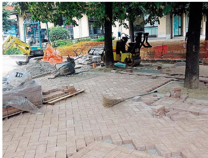
LAVORI Intervento in corso a Casinalbo
