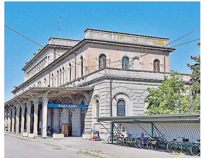
INTERVENTO La zona della stazione piccola
