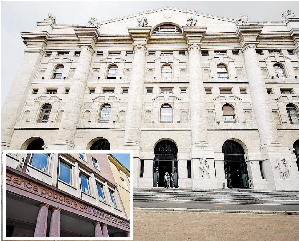
PALAZZO MEZZANOTTE La sede della Borsa a Milano
