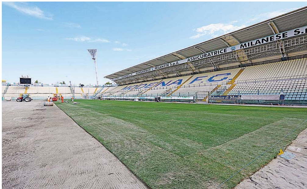
SOLO POCO PIU' DI UN ANNO FA I lavori per il rifacimento del campo al Braglia
