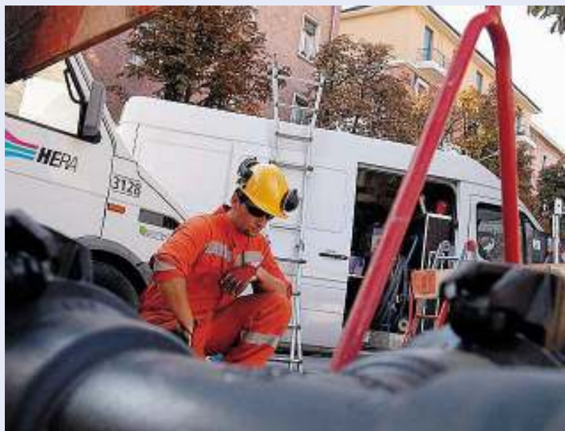
ULTIMO CANTIERE Con i lavori in avvio si conclude l'iter di rinnovamento dell'acquedotto vignolese iniziato tre anni fa e portato avanti per successivi stralci
